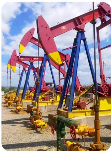
Unidade de Bombeamento de Balanço/Viga
